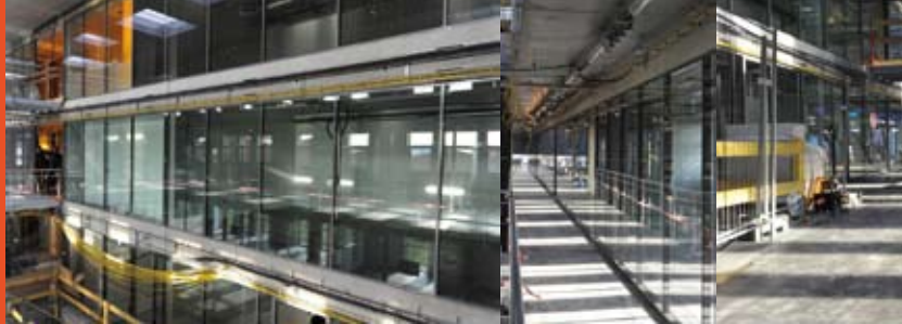
1er et 2ème étage cloison vitrée toute hauteur dormant sur le vide formant garde corps
