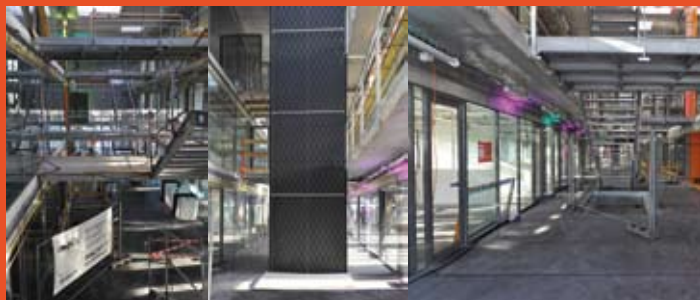
Vue d'ensemble 3 niveaux
